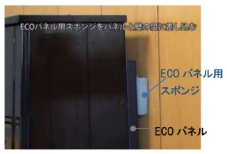
ECO パネルを固定する為に、ECO パネルと壁の間に スポンジを差し込みます。
